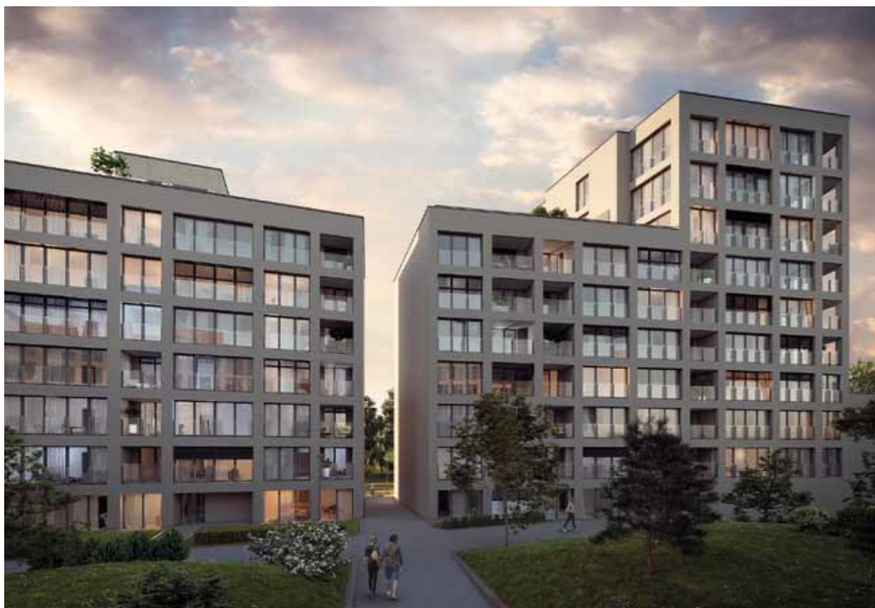
Bytový dům 4. etapy se skládá ze dvou nadzemních částí o výšce osmi až deseti podlaží.
