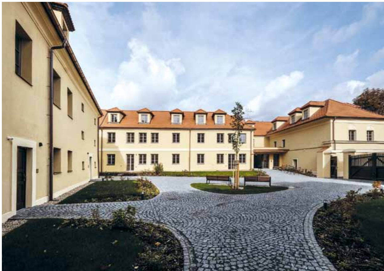
Residence Hendlův dvůr, Praha – Hanspaulka
