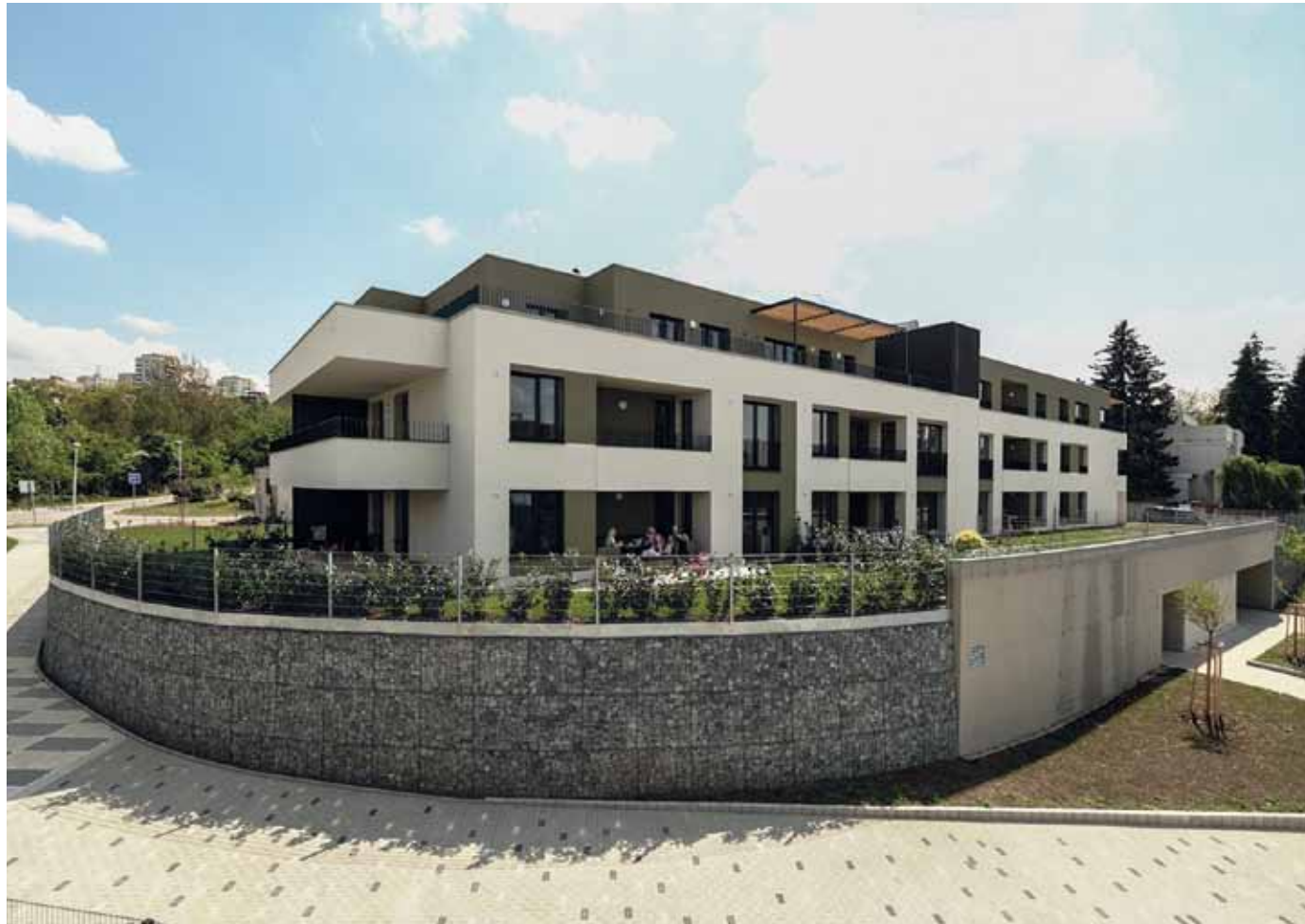
Bytové domy Elča, Emča, projekt U cukrovaru, Praha 12 – Modřany
