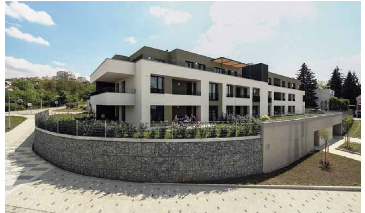
Bytové domy Elča, Emča, projekt U cukrovaru, Praha 12 – Modřany
