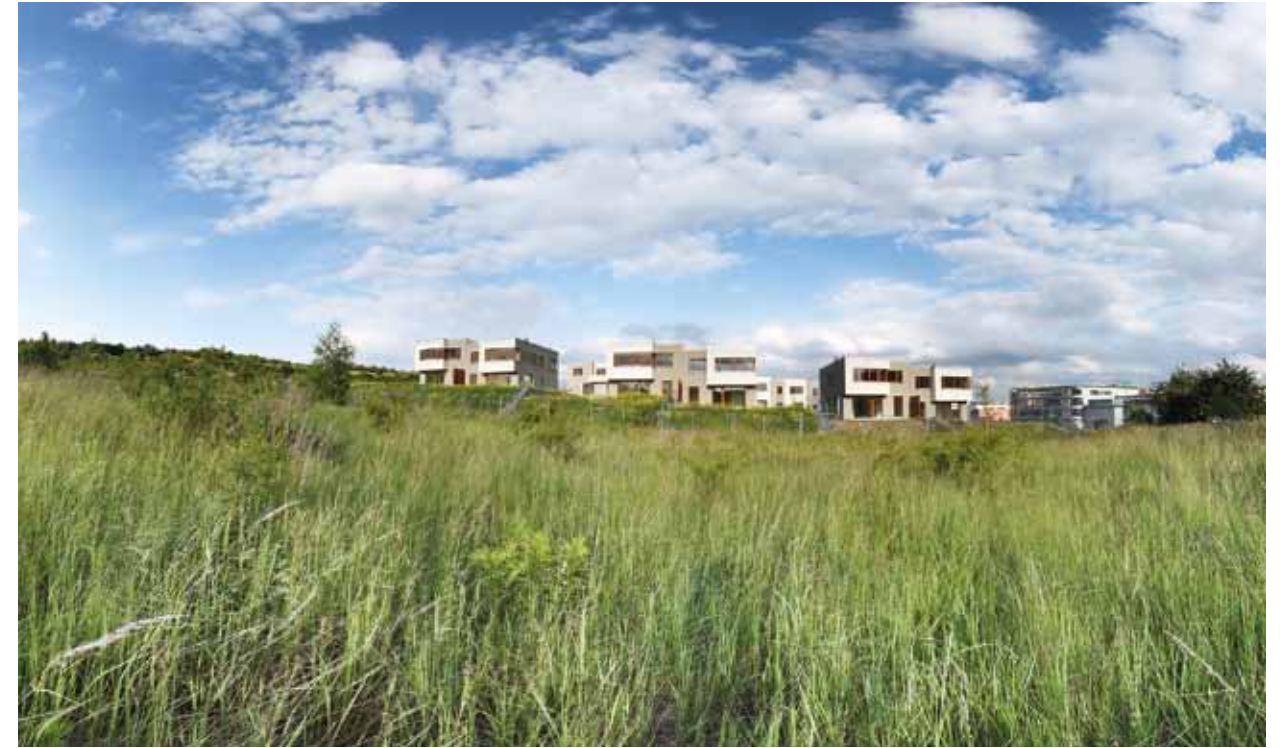
Rezidenční čtvrť Botanica, Praha 5 - Jinonice
