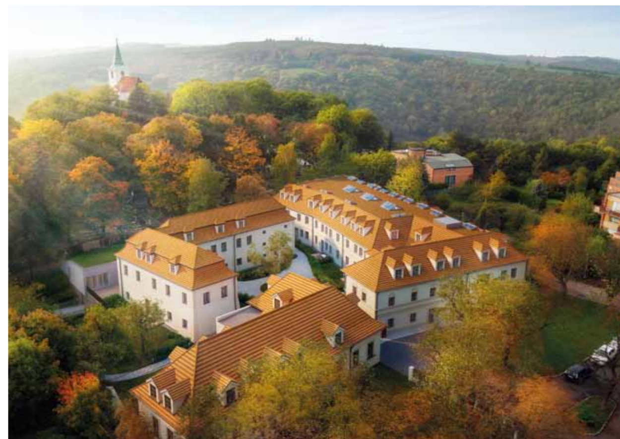
Rezidence Hendlův dvůr, Praha – Hanspaulka
