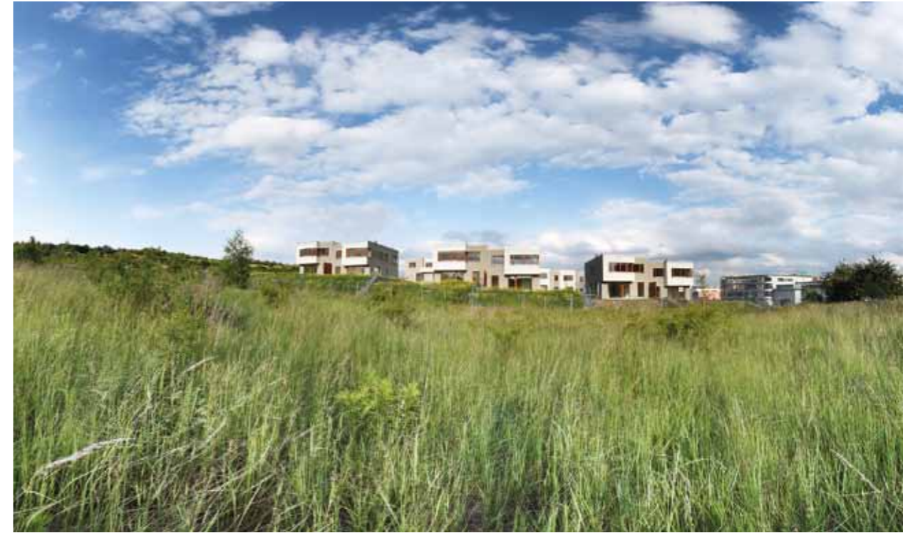
Rezidenční čtvrť Botanica, Praha – Jinonice
