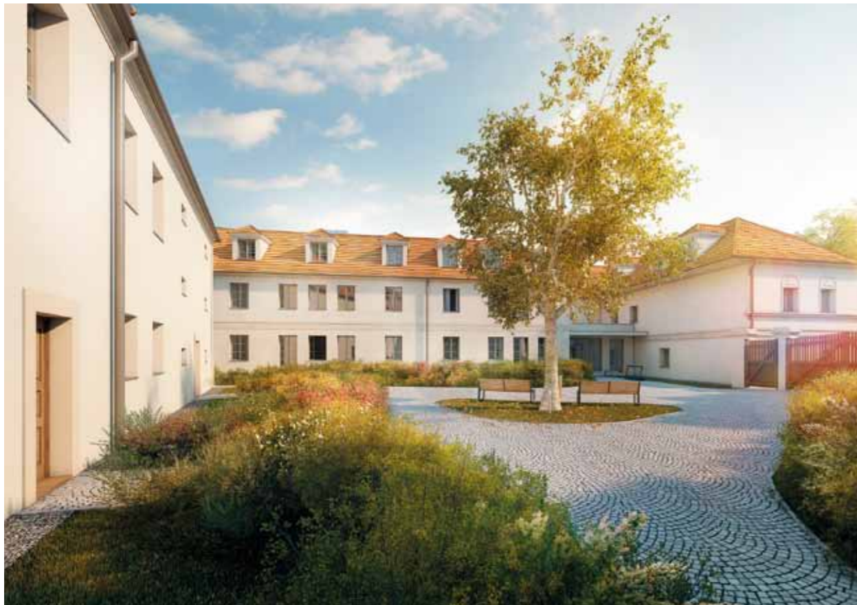
Rezidence Hendlův dvůr, Praha – Hanspaulka
